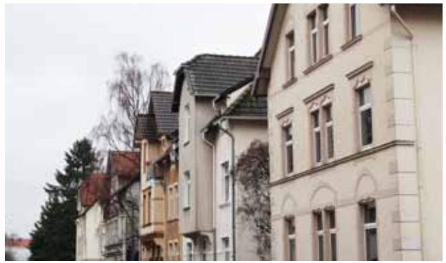
Abb. 29: Gebäude Meller Str.
