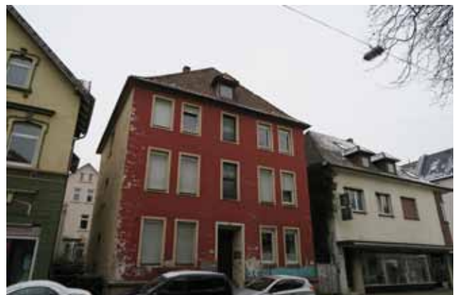
Abb. 100: Fassade südliche August-Bebel-Straße
