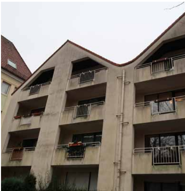
Abb. 87: Fassade Nelson-Mandela Platz
